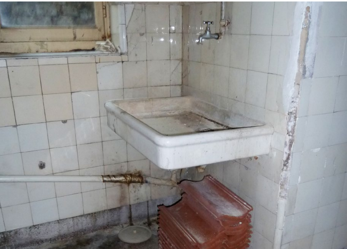
Abb. 5: Spülstein in der ehemalige Küche im Souterrain des Hauses der Autorin, vor Renovierung
