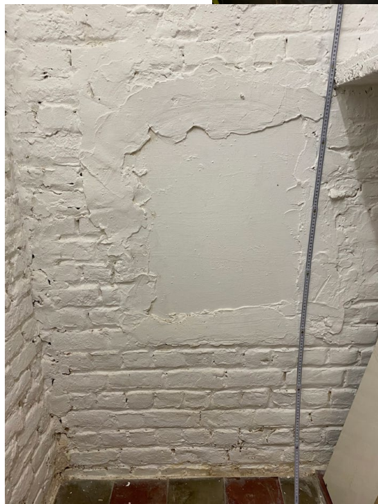
Abb. 1 und 2: Spuren von ehemaligen Durchbrüchen im Keller des Hauses der Autorin
