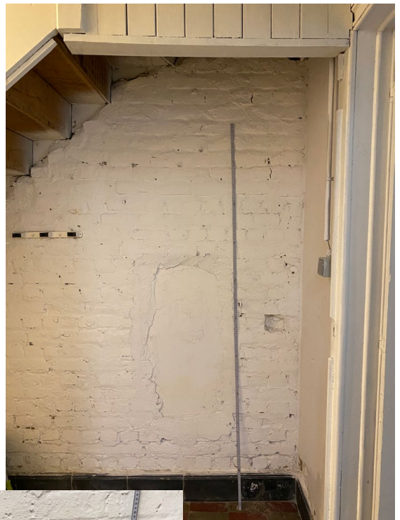
Abb. 1 und 2: Spuren von ehemaligen Durchbrüchen im Keller des Hauses der Autorin
